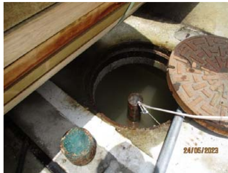
บ่อสังเกตการณ์น้ำใต้ดินท้ายน้ำ ของโรงงานผลิตสารโอเลฟินส์ โรงที่ 1/2
